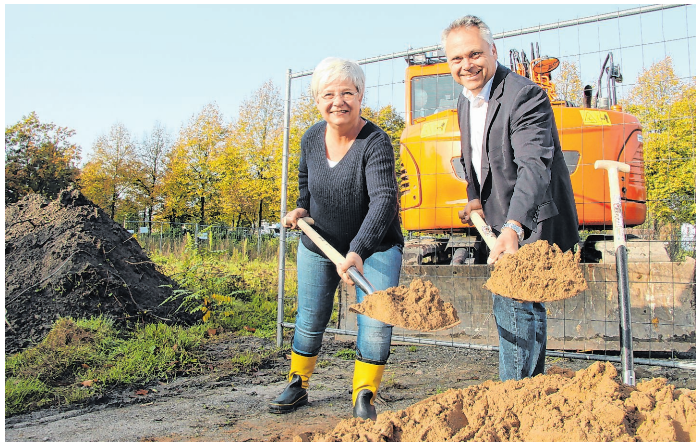
Jetzt geht's los: Marion Rieso-Wiege und Roland Thomas mit dem symbolischen ersten Spatenstich auf der Baustelle. Die Kita „Leuchtturm“ soll schon zum nächsten Kindergartenjahr ihre Tore an der Riestestraße öffnen.
